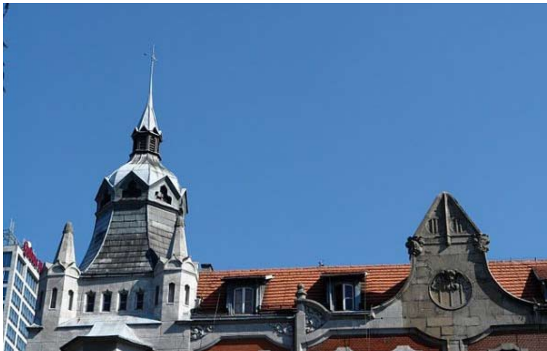
Widok na poddasze Andrzeja i Urszuli przy Piastowskiej 1 w Katowicach, 2009 r.
